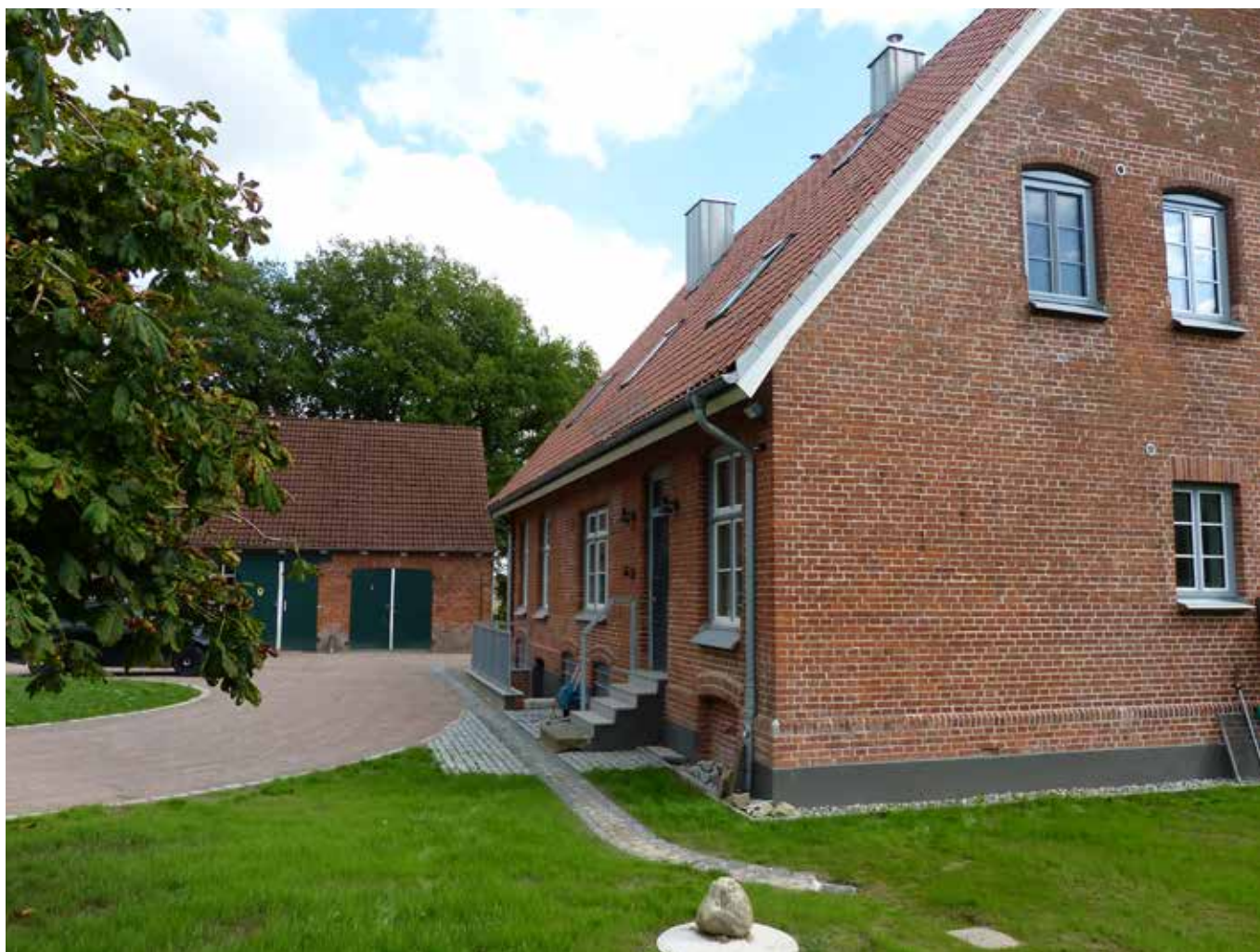
Blick auf das Wohnhaus und Nebengebäude
