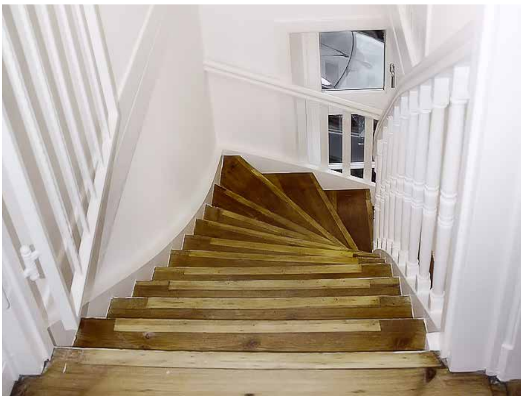
Blick auf die aufgearbeitete Holztreppe in das EG
